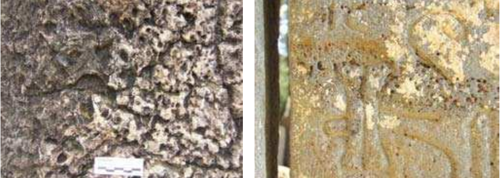
Şekil 3.19. Kumtaşında (yukarıda) ve bazalt taşında gözlenen Alveolar ayrışma.
