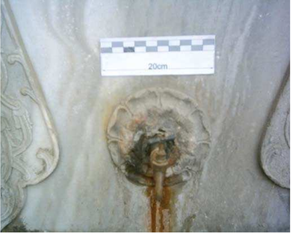
Şekil 3.42. Mermer çeşmede kullanılmış olan musluğun neden olduğu demir oksitli renklenme (Hızır Bey Camii, Kırklareli).
