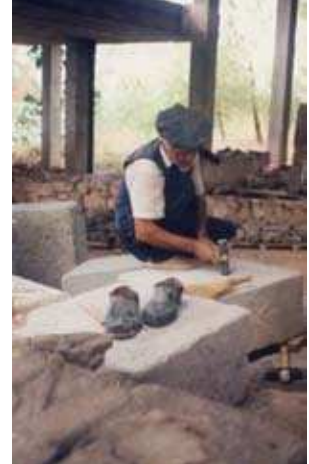
Şekil 2.15. Bitlis'in Ahlat ilçesindeki taş ustalarının taşları ocaktan halen geleneksel tekniklerle keski ve murç kullanarak çıkartmaları. Karatepe Açık Hava Müzesindeki geç Hitit çağı kalesinin duvar restorasyonunda Kahramanmaraş'ta hâlâ eski geleneksel usullerle çalışan taş ustalarından yararlanılmıştır (sağda).
