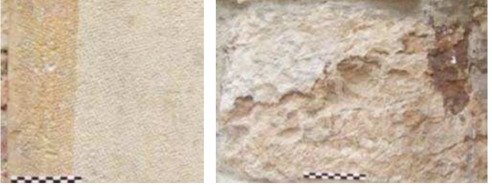
Şekil 3.45. Kumtaşı yüzeyinde görülen renk değişimi.
