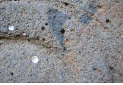
Şekil 3.4. Bazalt taşından yapılmış rölyefli orthostat yüzeyinde görülen küçük boyuttaki kırılmalar nedeniyle parça düşmeleri (Karatepe-Aslantaş Açık hava Müzesi, Kadırlı).
