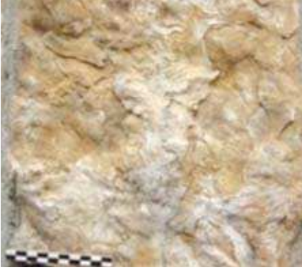
Şekil 3.38. Yapıların cephe taşlarında gözlenen kabuklanma.
