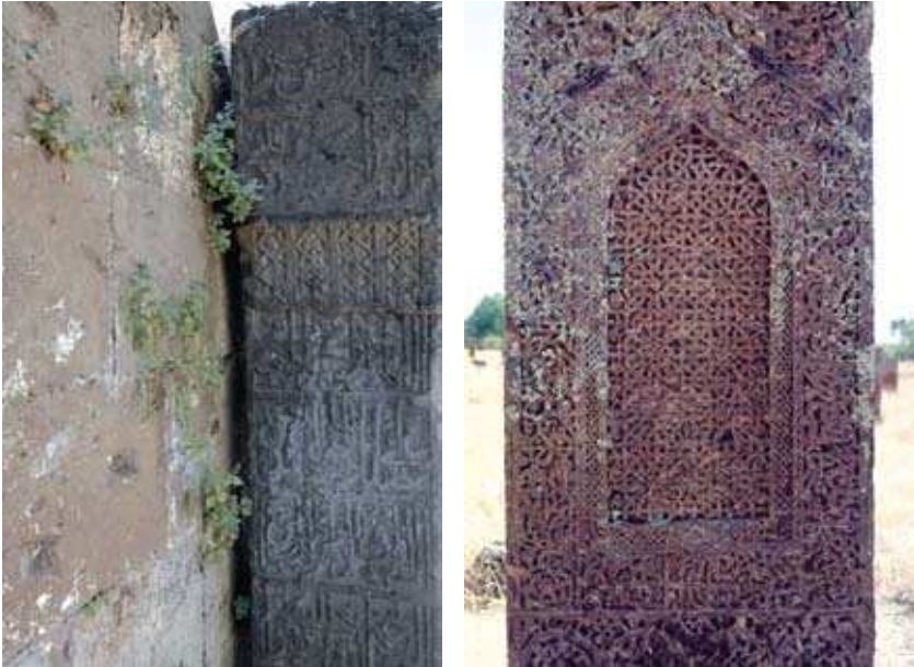
Şekil 3.65. Bitlis Şerefiye Camii duvarlarında (solda) ve XIII. yüzyıla ait kırmızı tüf taşından yapılmış Ahlat mezar taşlarında gözlenen yoğun liken yerleşimi.
