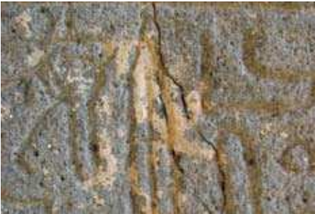
Şekil 3.6. Taşlarda görülen kendi yapısına bağlı olarak veya taş yapısından bağımsız olarak gelişen çatlak ve yarıklar.
