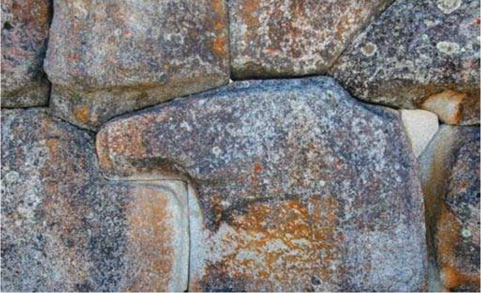
Şekil 3.64. Alacahöyük antik kenti duvarlarında gözlenen alg ve liken kolonizasyonu.
