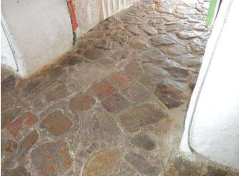
Şekil 3.53. Kolombiya'nın en eski ve korunmuş İspanyol kolonizasyonu dönemi şehri Villa de Leyva da eski bir han girişindeki taş döşemenin yoğun ziyaretçilerin oluşturduğu aşınma nedeniyle parlak bir görünüş edinmesi.
