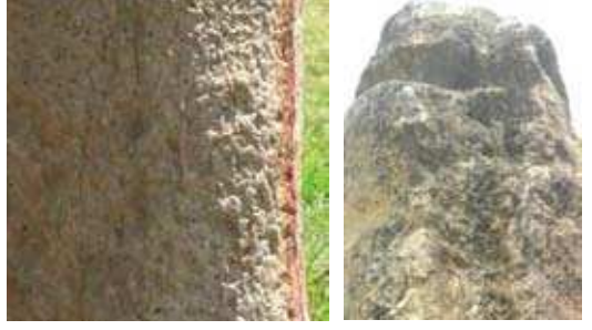
Şekil 3.5. Taş anıtlarda görülen taş yapısına bağlı çatlaklar.
