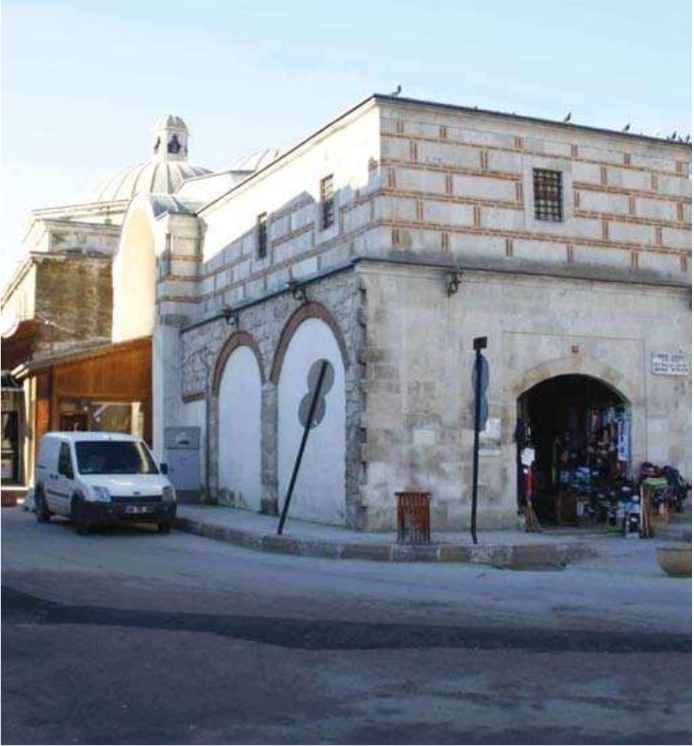
Şekil 2.19. Hızır Bey Külliyesi Arastası'nın cephelerine dayanarak inşa edilen yeni yapılaşmaların oluşturduğu görsel bozunum.
