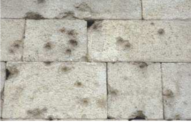
Şekil 3.29. Erzurum Murat Paşa Camii'nin duvarlarında savaş sırasında Rusların kullandıkları mermi izlerinin neden olduğu şok darbeler.
