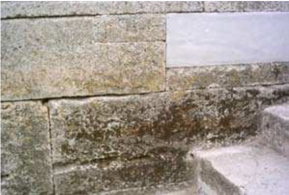
Şekil 3.63. Edirne Selimiye Camii arka giriş cephesinde zemine yakın bölgedeki fosilli kalker taşlarında gelişen biyolojik alterasyonlar.
