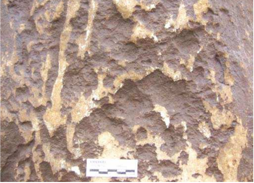
Şekil 3.25. Taşın yapısal karakterine bağlı olarak gelişebilen rölyef şeklindeki bozunma.
