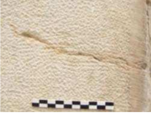
Şekil 3.4. Bazalt taşından yapılmış rölyefli orthostat yüzeyinde görülen küçük boyuttaki kırılmalar nedeniyle parça düşmeleri (Karatepe-Aslantaş Açık hava Müzesi, Kadırlı).
