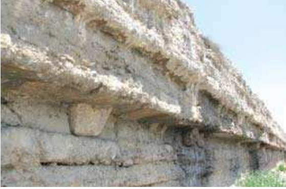
Şekil 3.40. Tarsus Donuktaş'ta duvar taşlarının üzerinde değişik kaynaklı yabancı madde birikimi.
