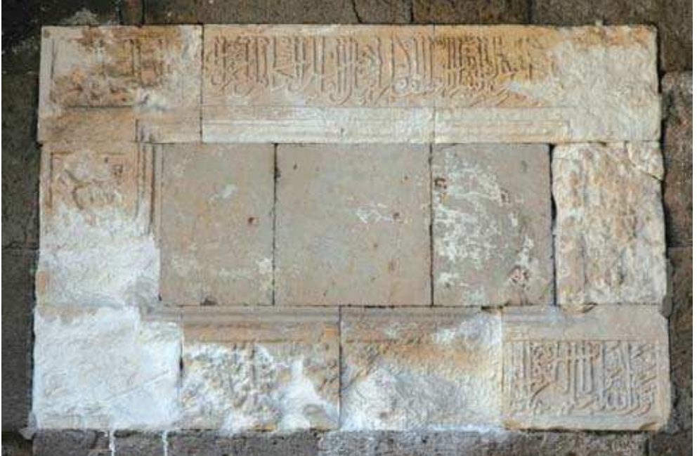
Şekil 3.51. Kireçtaşında görülen kalsitli kabuklanma (Bitlis Şerefli Camii).
