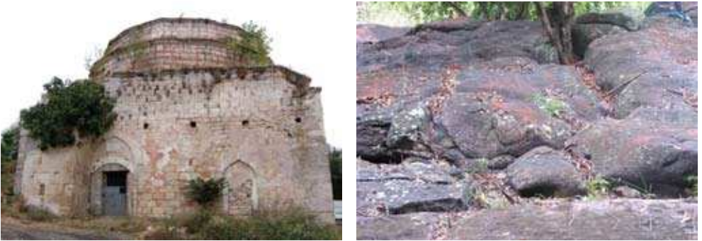
Şekil 2.6. Kırklareli / Vize Şerbetdar Hasan Bey Camii bakımsızlıktan akasya ve incir ağaçlarının yapı üzerinde yetişerek yapıda oluşturdukları hasar (üstte). Bakımsızlık nedeniyle bitki örtüsüyle kaplanmış Kolombiya'nın Aipe şehri yakınlarındaki doğal ana kayaca işlenmiş kaya yazıtları grubu.
