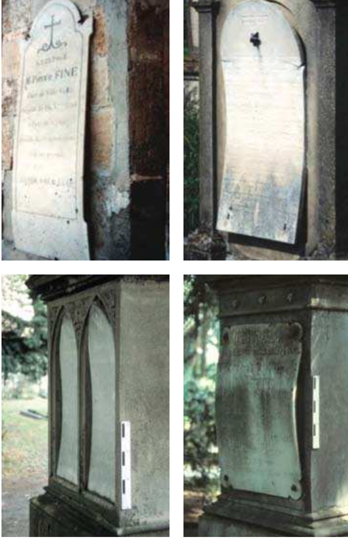
Şekil 3.8. Daha çok mermer taşlarda görülen deformasyon veya bükülmeye örnekler: Fransa Queyras bölgesindeki Ville Vieille şatosu (sol üstte); Fransa, Sélestat (Haut-Rhin) mezarlığı (sağ üstte); Almanya Köln mezarlığı (sol altta), Almanya Bonn eski mezarlığı (sağ altta) (ICOMOS-ISCS, 2008).
