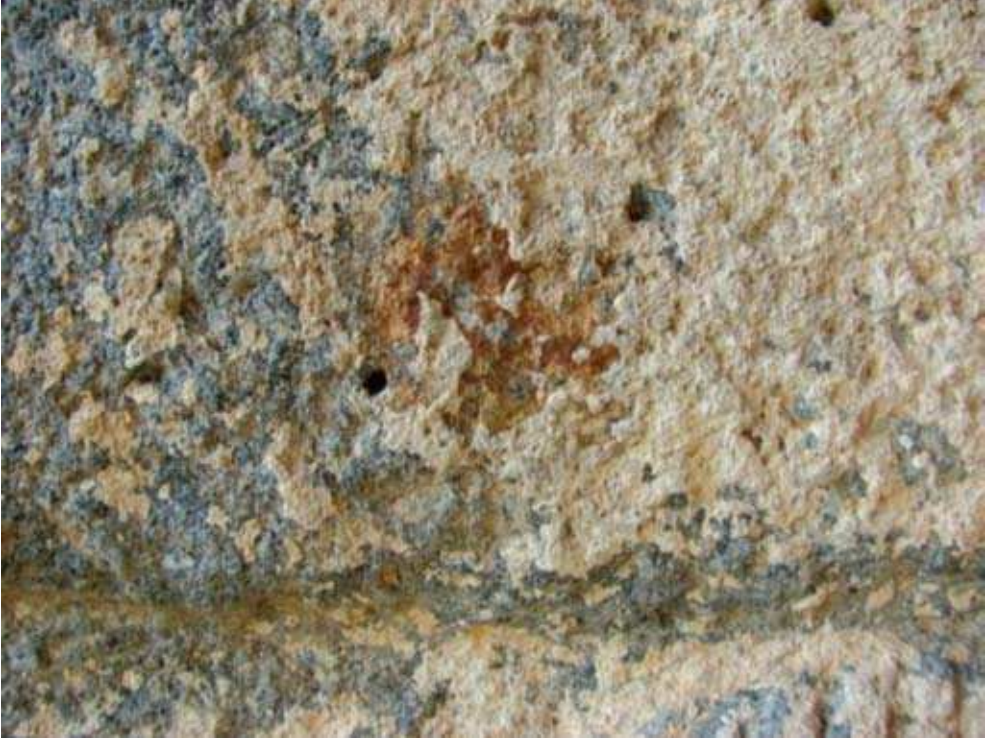
Şekil 3.48. Bazalt taşından yapılmış orthostatların yüzeylerinde görülen renk değişimi (Karatepe Açık Hava Müzesi, Kadirli).
