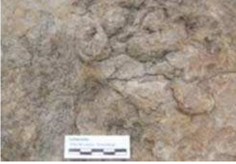
Şekil 3.14. Taş yüzeyindeki ince tabaka oluşumu.
