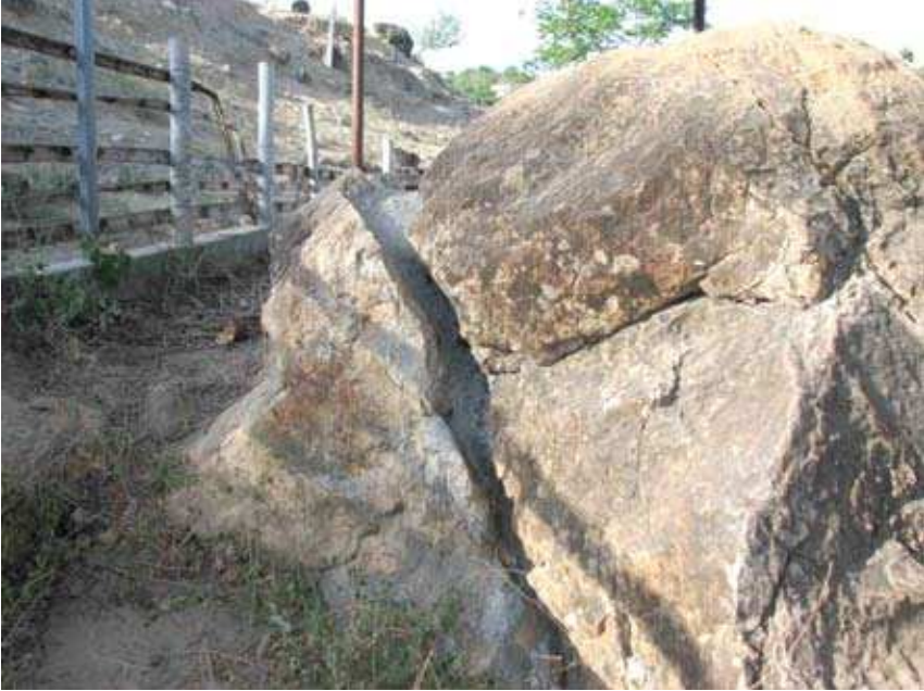
Şekil 2.17. Kolombiya'daki San Agustin Arkeolojik Parkı içerisindeki volkanik tüften yapılmış olan heykelerde restorasyon amacıyla çimento kullanılarak yapıştırılması ile yine Kolombiya-Aipe'deki en tanınmış olan "Boyalı Kaya" anıtında, taşın çatlamasından sonra kırılarak ayrılmasının engellenmesi için çatlak bölümün çimento ile doldurularak onarılması.
