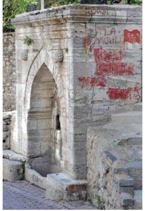
Şekil 2.23. Giriş kapısının fark edilmesini sağlamak amacıyla, "güzel" gözükmesi için amatörce restorasyon denemeleri de yine insan kaynaklı bozunmalar olarak nitelendirilmektedir (solda). İstanbul Sultanahmet'te bir Osmanlı çeşmesinin, duvarlarına uygulanan grafitilerin sonucundaki görsel bozunmalar.
