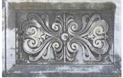
Şekil 3.57. Fethiye kaya mezarlarının birinde değişik nedenlerle oluşan kirlenme (solda) ile Didyma antik kentindeki mermer bir mimari ayrıntı yüzeyinde gözlenen kirlenme.
