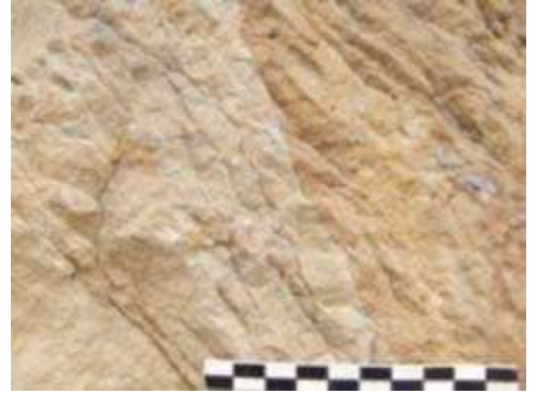
Şekil 3.6. Taşlarda görülen kendi yapısına bağlı olarak veya taş yapısından bağımsız olarak gelişen çatlak ve yarıklar.
