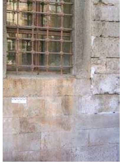
Şekil 3.43. Pencereye takılan demirin neden olduğu renklenme (Hızır Bey Külliyesi Hamamı, Kırklareli).
