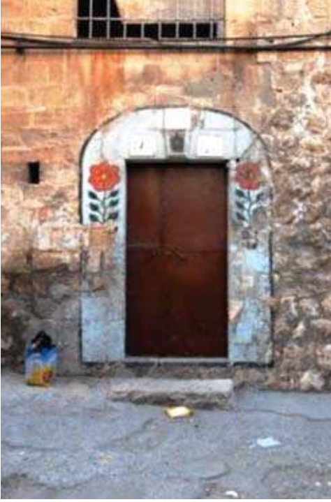
Şekil 2.23. Giriş kapısının fark edilmesini sağlamak amacıyla, "güzel" gözükmesi için amatörce restorasyon denemeleri de yine insan kaynaklı bozunmalar olarak nitelendirilmektedir (solda). İstanbul Sultanahmet'te bir Osmanlı çeşmesinin, duvarlarına uygulanan grafitilerin sonucundaki görsel bozunmalar.
