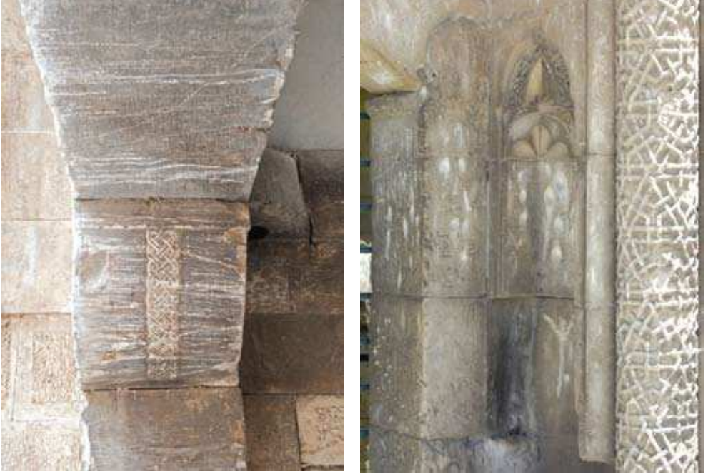
Şekil 3.31. Urfa Birecik'teki bir han girişinde, yoğun araç trafiği nedeniyle kapı taşlarında gözlenen çizikler ve aşınma (solda) ile Tercan'daki Mama Hatun Kümbeti giriş kapısında yine ziyaretçilerin neden olduğu hasarlar.
