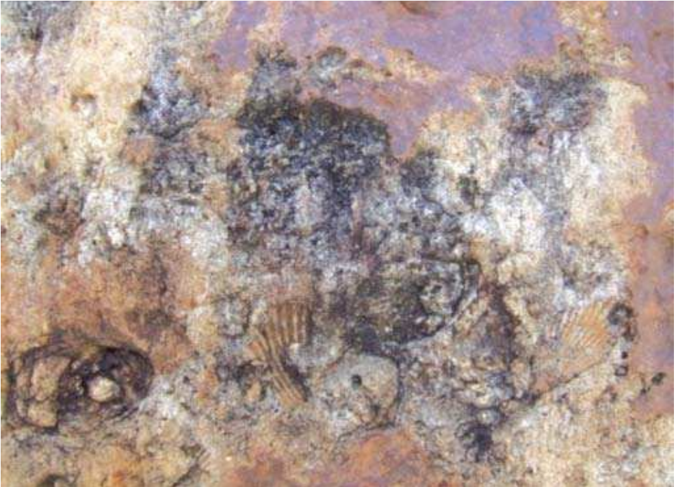
Şekil 3.26. Fosil içerikli kumtaşlarında gözlenen diferansiyel erozyon veya rölyef şeklindeki bozunma.
