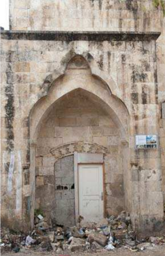
Şekil 3.41. Adana'daki Yeni Hamam'ın arka bölümündeki kapısının çevre insanlarınca çöplük olarak kullanılması sonucunda oluşan yabancı madde birikimi.
