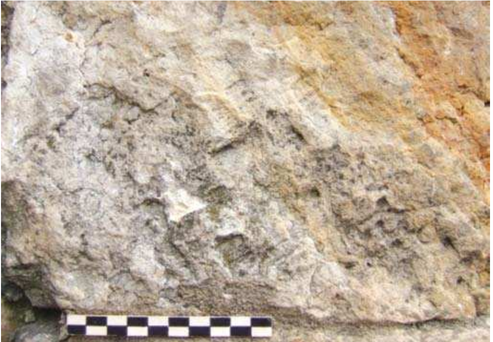
Şekil 3.58. Bakterilerin neden olduğu mikrobiyolojik kirlenme.
