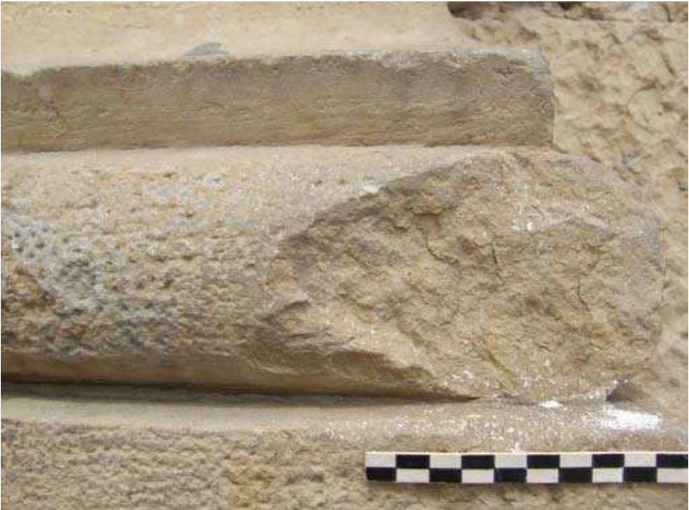
Şekil 3.3. Bir darbe sonucunda, kırılma nedeniyle oluşan materyal kaybı (Santa Barbara de Usaquen Kilisesi, Kolombiya).
