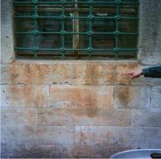
Şekil 3.43. Pencereye takılan demirin neden olduğu renklenme (Hızır Bey Külliyesi Hamamı, Kırklareli).
