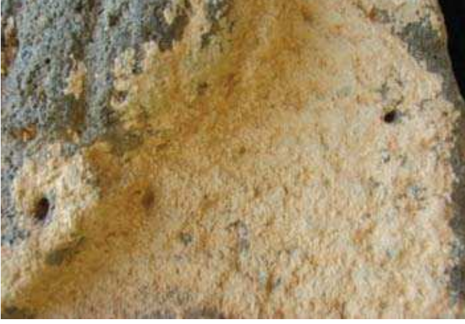
Şekil 3.13. Kabartmalarda gözlenen, kalınlığı 1 mm ile 8 mm arasında değişen kalkerli tabakalaşma.
