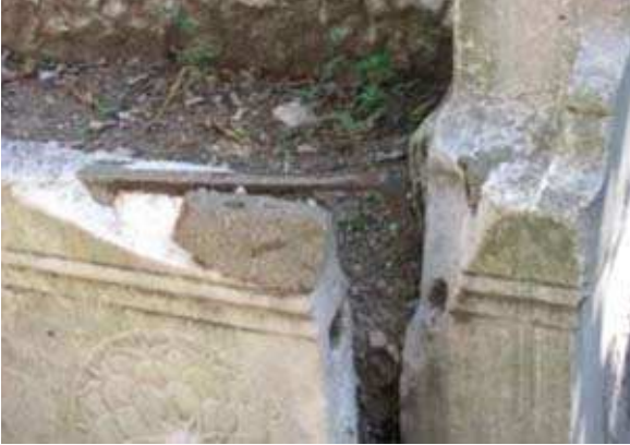
Şekil 3.10. İstanbul'daki Müslüman mezarlıklarından birinde gözlenen metal kenedin korozyonuyla oluşan patlamanın sonuncundaki kopma.
