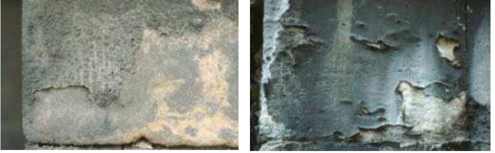
Şekil 3.9. Taş yüzeyinde oluşan kabarma: Almanya, Magdeburg Katedrali (solda) ile yine Almanya Naumburg Katedrali (ICOMOS 2008).
