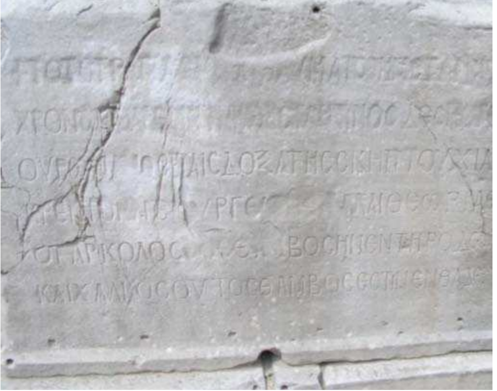
Şekil 3.1. İstanbul Sultanahmet'te bulunan hipodromun ortasındaki Sultanahmet örme dikilitaşının kaidesinde gözlenen çatlaklar dizisi.
